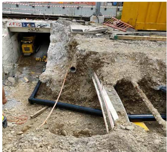
Die Projektarbeiten K394 Unteräsch-/Dorfstrasse wurden über das gesamte Jahr 2023 weitergeführt. In den Projektabschnitten konnten weitere 360 Meter Grauguss- durch PE-Leitungen ersetzt werden.
