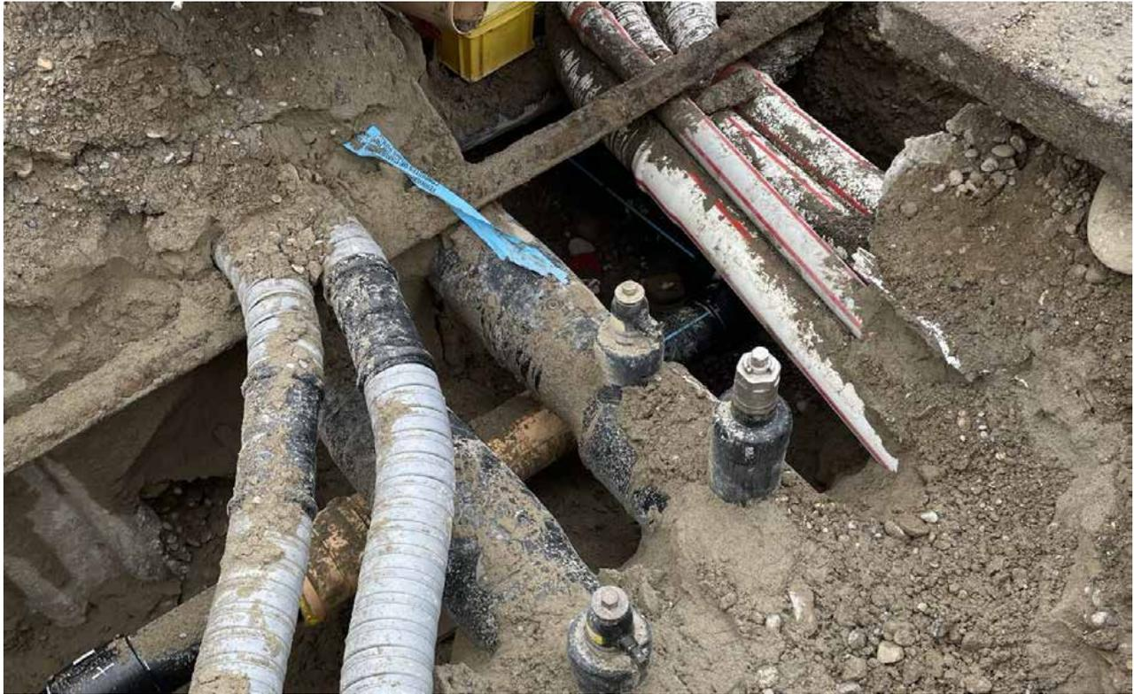
Unter den Fernwärme- und EW-Leitungen ist die Wasserleitung kaum zu erkennen (Talstrasse, Wildegg)
