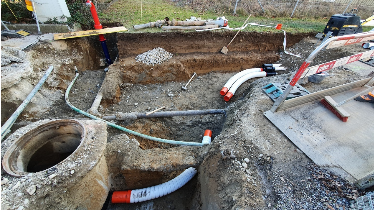
Werkleitungssanierungen Tannenweg, Niederlenz
