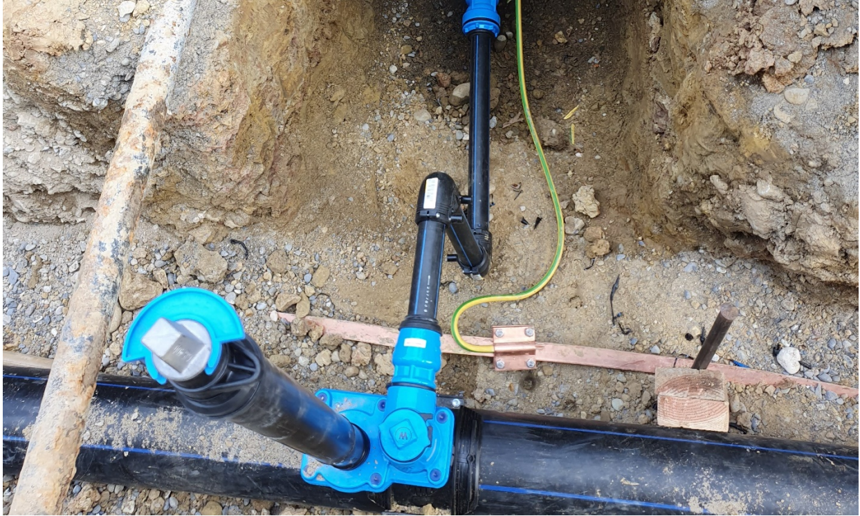
Leitungsbau Böllisteig/Tannenweg, Niederlenz
