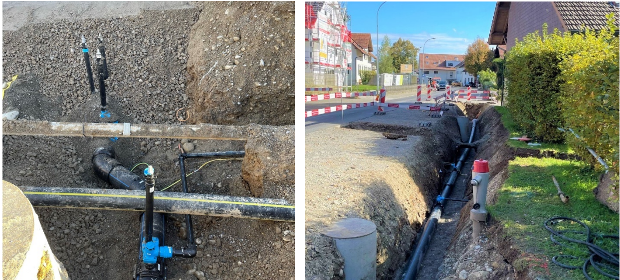
Leitungsbau Unteräschstrasse, Möriken
