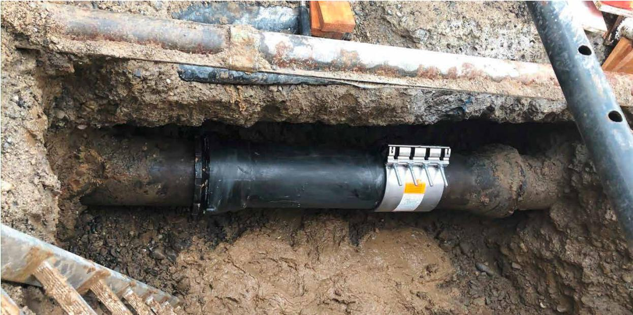
Reparatur mit einer Rohrbruchselle an der Wildeggerstrasse, Niederlenz
