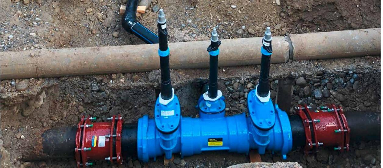
Anschluss der Hauptwasserleitung in der Lehmgrube, Möriken
