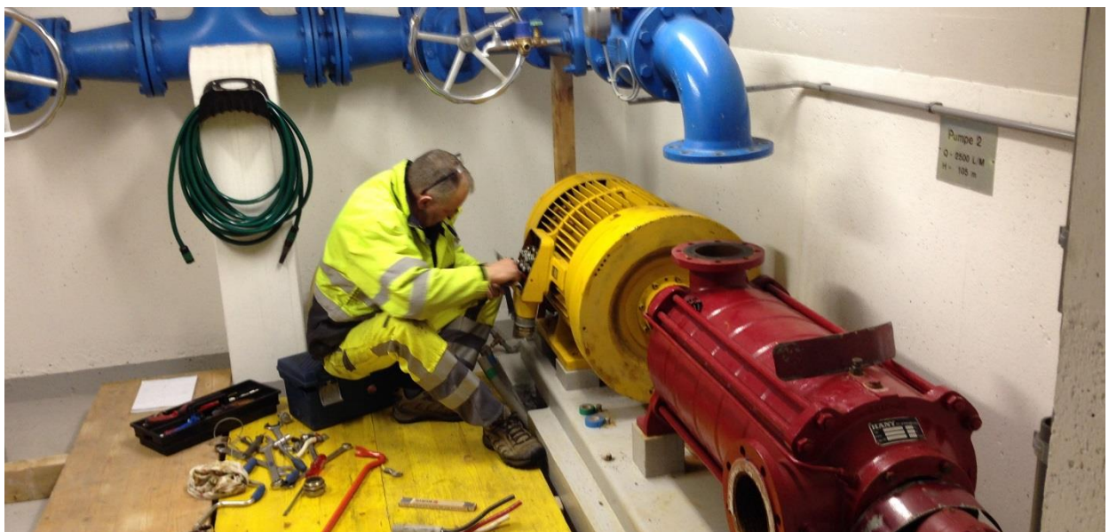
Grundwasserpumpe im GWPW Grienmatt
