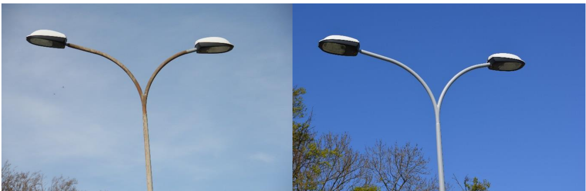
Ein durch Rost gezeichneter Kandelaber, welcher nach der Sanierung in neuem Glanz erstrahlt – Niederlenzerstrasse in Möriken
