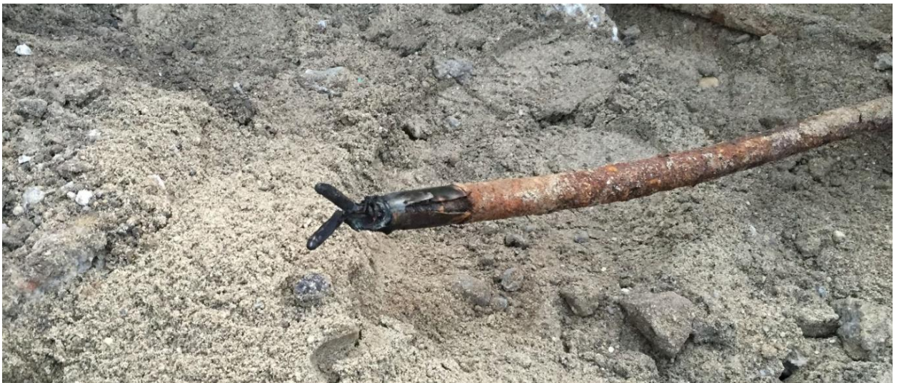
Kabelschaden an der alten Wildeggerstrasse in Niederlenz
