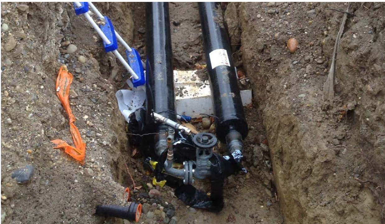
Fernwärmehauptleitung mit Umschluss (Hornimattstrasse in Wildegg)
