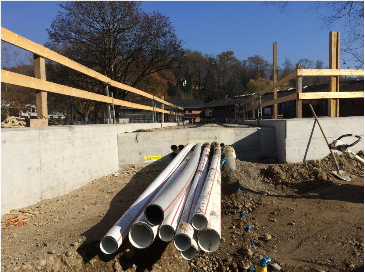
In die neue Paradiesbrücke eingelegte Werkleitungsrohre (Wildegg)
