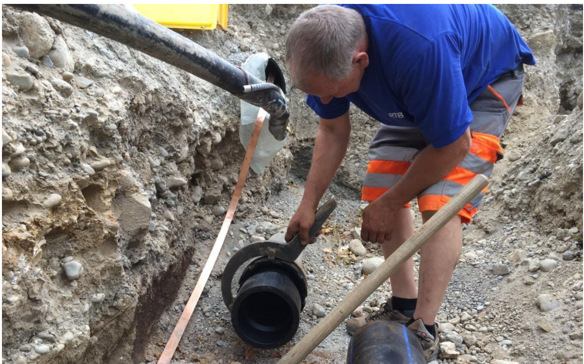
Montage Übergangstück Guss / Kunststoff (Lauéstrasse in Wildegg)
