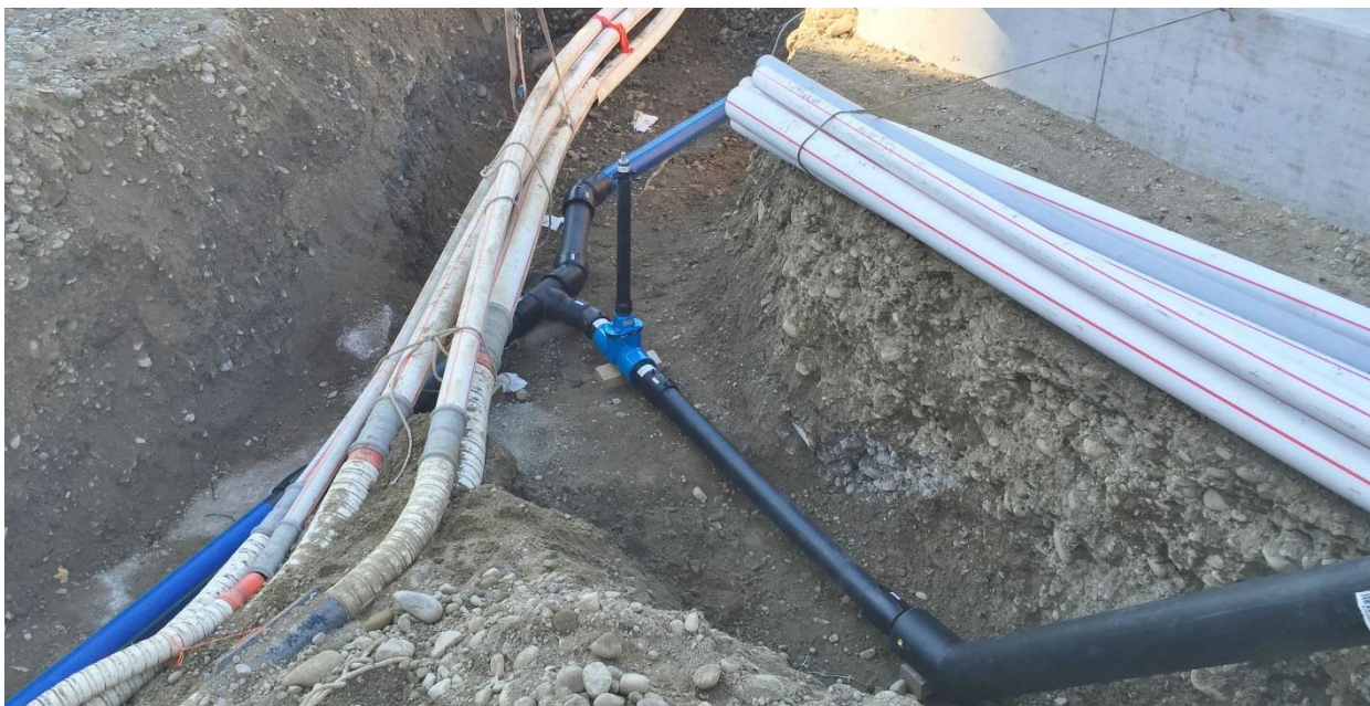
Wasserleitungszusammenschluss Paradiesbrücke / Lauétrasse in Wildegg
